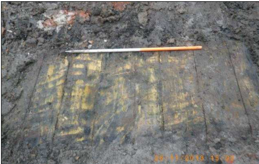
Afbeelding 13. Detail van de houten fundering van (en onder) de inlaat.
