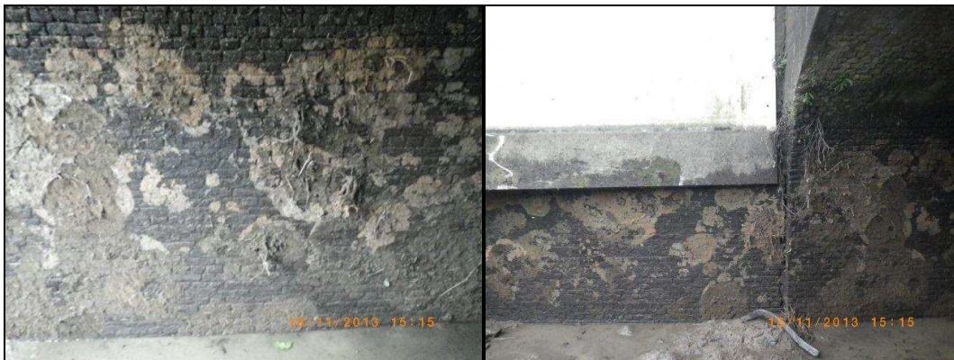
Afbeelding 9. Detail van het aangetroffen muurwerk. Rechts: westzijde inlaat met gewelf. Links: oostzijde, in gewelf.
