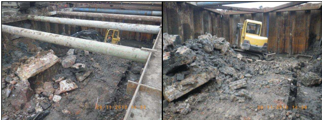
Afbeelding 6. Beperkingen deel 3: Beperkte ruimte en diepte aan het eind van de sloop.
