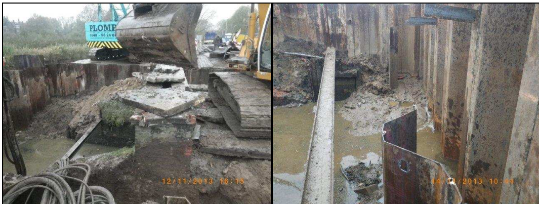
Afbeelding 5. Beperkingen deel 2: beperkte ruimte in werkput in het begin.
