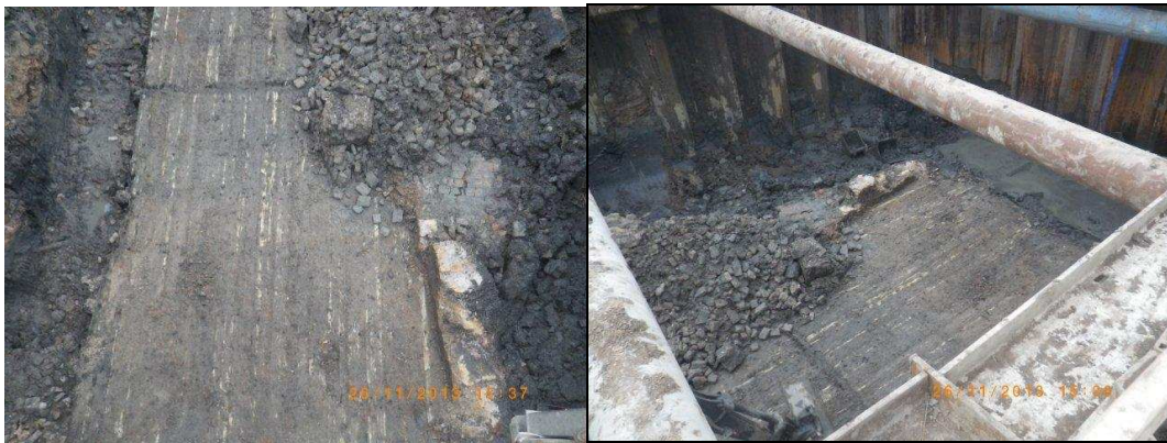
Afbeelding 12. Houten fundering van (en onder) inlaat (gezien vanuit de dijk richting het zuidoosten; richting de Enkele Wiericke).
