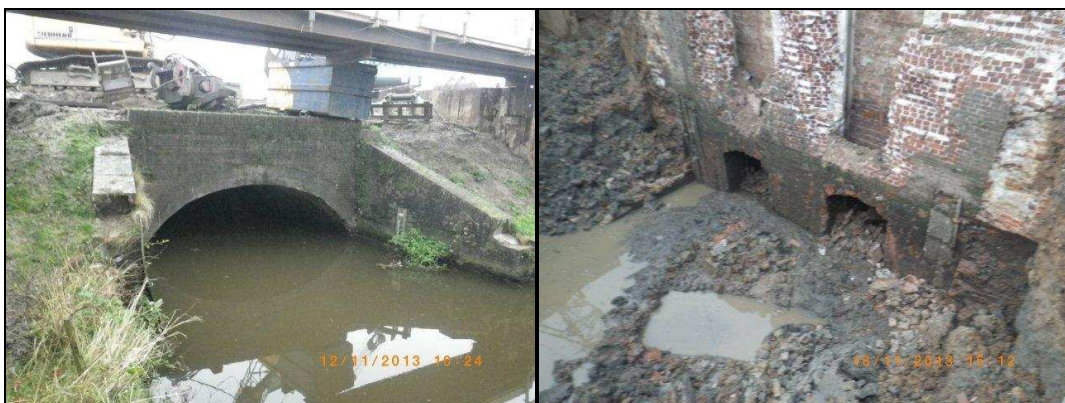
Afbeelding 8. Rechts: voorzijde inlaat (aan kant van Hollandse IJssel). Link: achterzijde inlaat (aan kant Enkele Wiericke).
